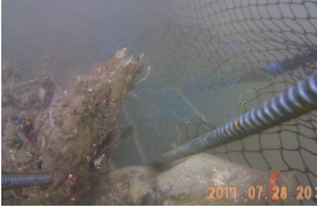
Şekil 4.2.35. Izgaranın açıklıklarını bloke eden çöpler.
